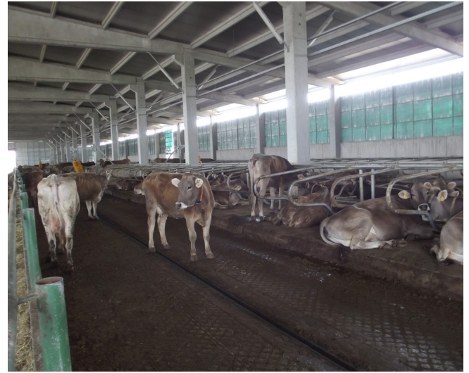
Resim 10. Duraklar hayvan refahına uygun tasarlanmalı ve inşa edilmelidirler.
